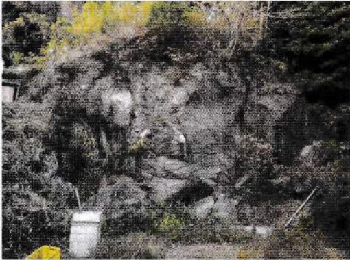
図6 西町大塚神社裏の資材工場の崖高さ8mの宇土溶岩が露出している。
