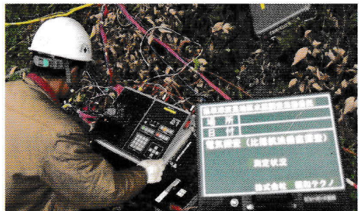
写真1 測定機材(上)と測定状況(下)
