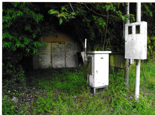
図2: 波佐見鉱山の坑口、九州大学の地震観測装置
