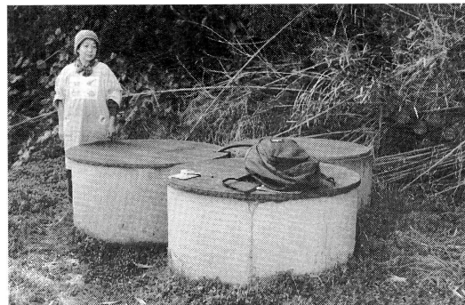
10 山下商店・旅館では、3基の浅井戸より揚水している。(名切地区)
