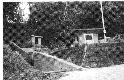
11 黒島港に近い本村地区の水源地帯の黒島漁業組合の集配水施設
